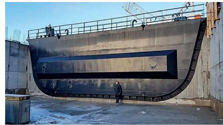
Den specialkonstruerade dockporten på plats i december 2018. (ÅSM)
